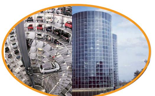
Parking silo équipé d'un ascenseur pour voiture entièrement robotisée de plus de 20 étages avec 48 mètres de haut qui accueillent 400 voitures, ce prototype est expérimenté à Wolfsburg en Allemagne par Volkswagen
