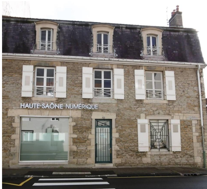
Photo 3 : Photo de la structure, prise le 05/02/19 par F.Ruby à Vesoul
